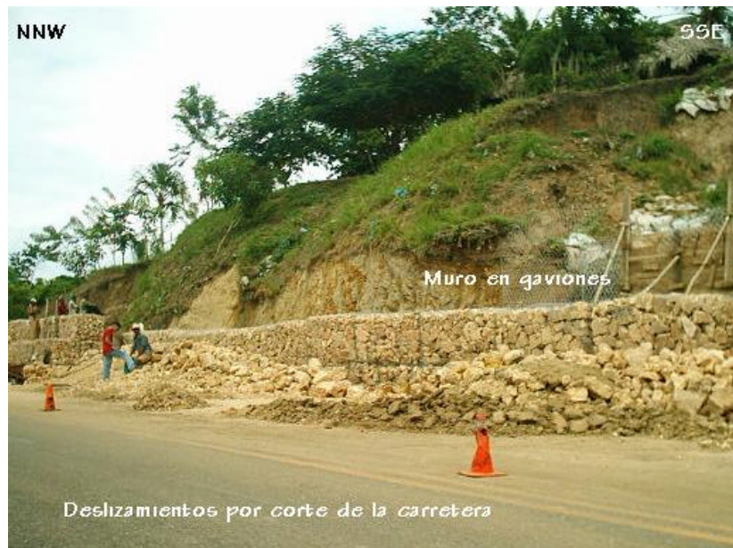
Fotografía 10.1. Deslizamientos sobre la vía que conduce de Lorica a san Bernardo del viento. Nótase que el origen es debido al corte de la carretera
